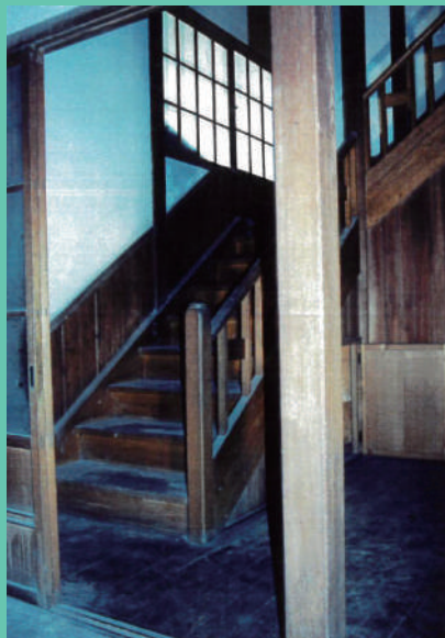
旧木内別邸 解体前の2階への階段
